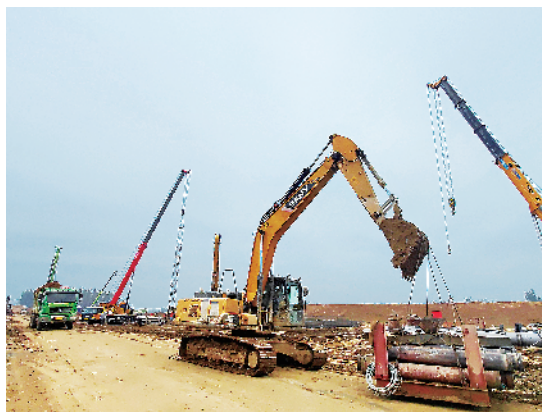
紧张施工中的周口港中心作业区。
