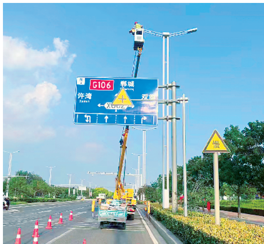
工作人员维修故障路灯。
