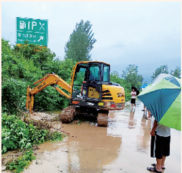
7月17日，川汇区淮河路街道党员干部带领群众清理沟渠堵塞物，保障排水畅通。
