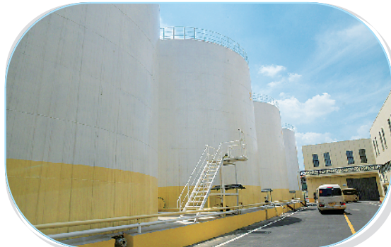
周口市康之源粮油食品有限公司年加工10万吨食用植物油项目(新开工)。
