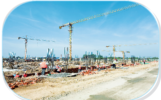
闰帛纺织印染工业园项目(新开工)。
