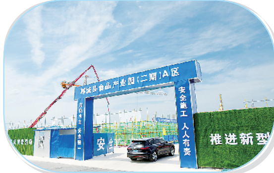
郸城县高新区食品产业园二期项目(新开工)。
