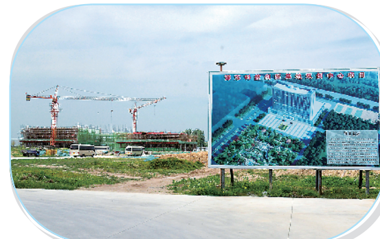
豫东科技创新产业基地双创中心项目(新开工)。
