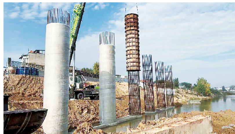
文昌大道跨贾鲁河桥施工现场
