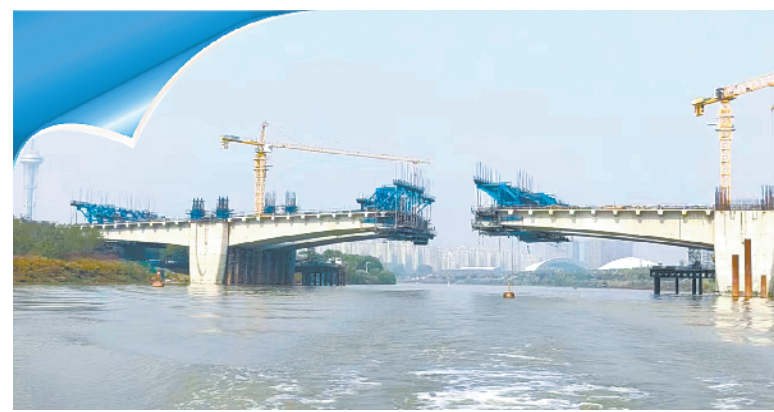
昨日，在周口市中心城区七一路东延工程跨沙颍河大桥施工现场，工人正在进行紧张施工。据悉，七一路跨沙颍河大桥全长985米，主桥309米，桥宽45米。目前，大桥引桥现浇箱梁已全部完成，主桥即将合龙。记者付永奇摄②16
