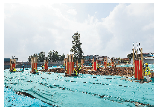
西华经开区电子产业园项目
